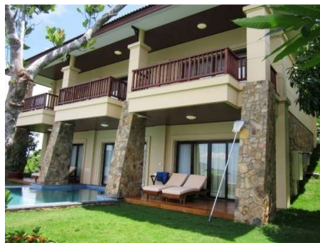
Diềm mái và lan can biệt thự
